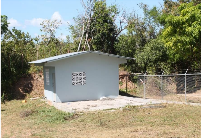
RELLENO SANITARIO SEMI MECANICO DE RIO DE JESUS
